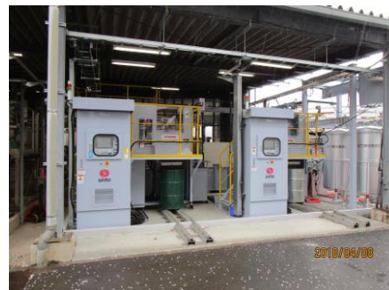
工程排水処理施設更新 [川崎]
