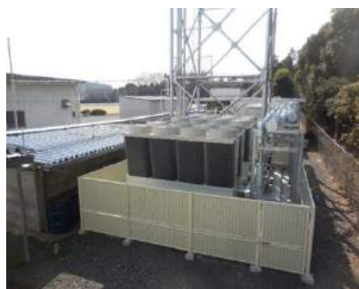
冷・温水熱源機器更新 [宇都宮]
