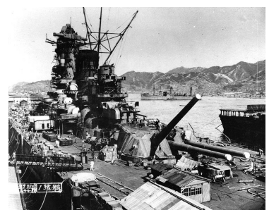
建造中の戦艦「大和」 (写真提供・大和ミュージアム)
