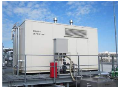
屋上熱源設備
